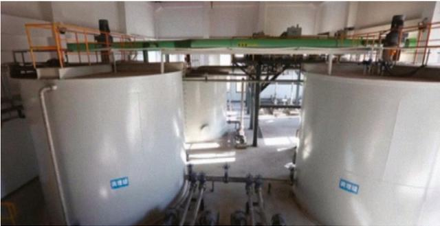
Рис. 13. Станция дозирования флокулянта
