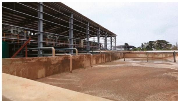
Рис. 22. Лагуна с поднятым осадком
