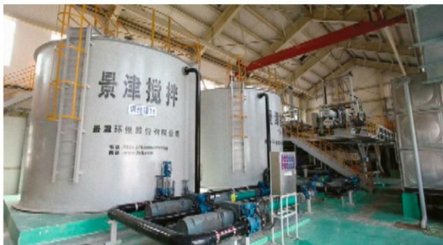
Рис. 5. Станция дозирования флокулянта
